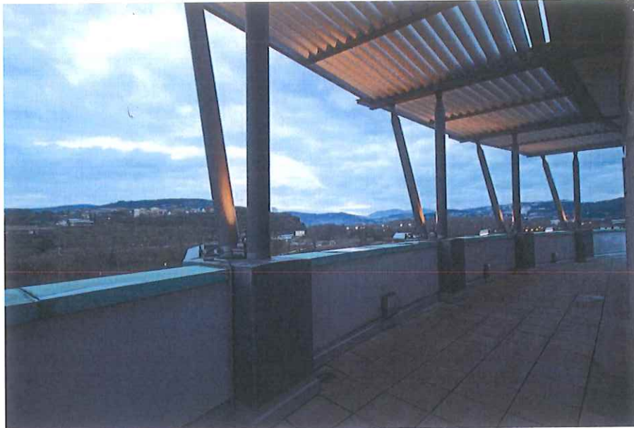
Terrazzo piano quarto
